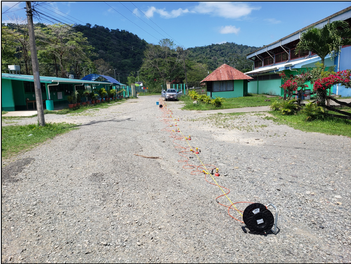
Fotografía 1. Ejecución del ensayo MASW-8.
