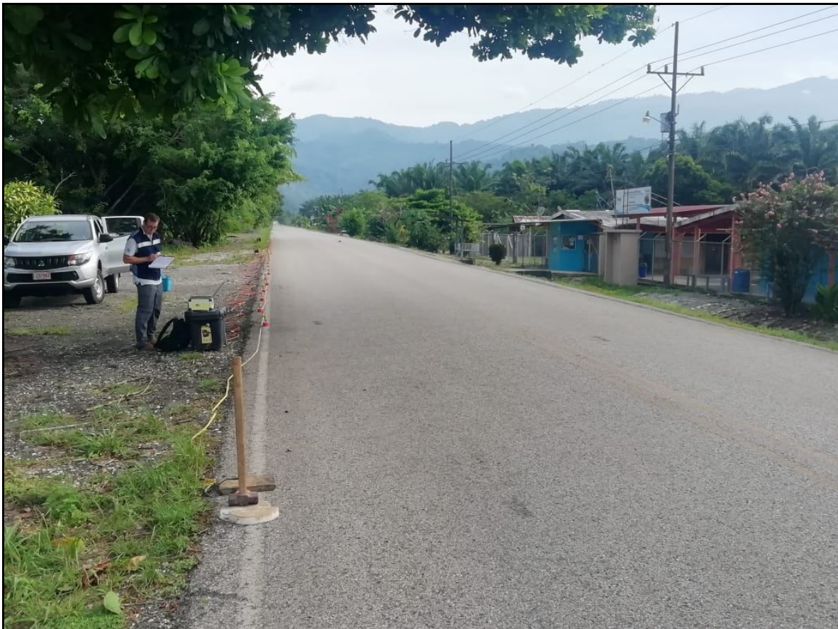
Fotografía 2. Ejecución del ensayo MASW-2.
