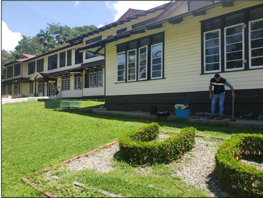
Fotografía 1: Ejecución de ensayo MASW-5
