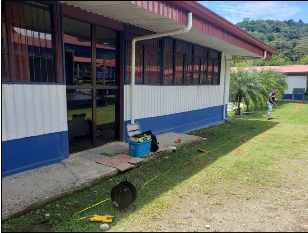
Fotografía 1: Ejecución de ensayo MASW-6
