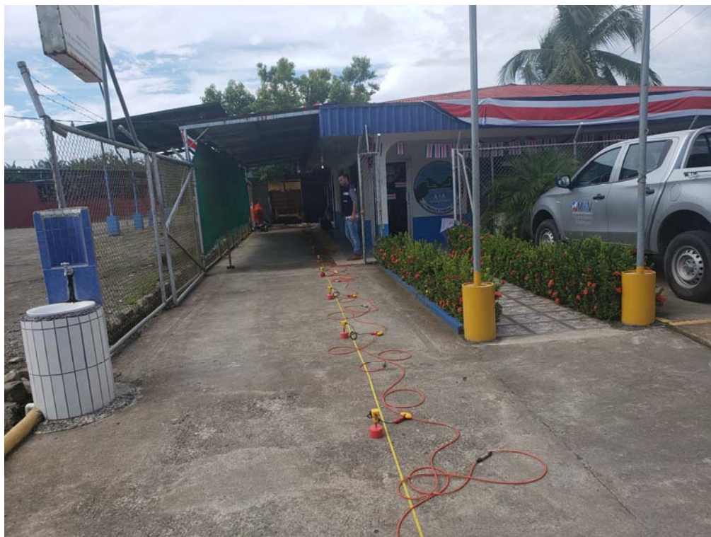
Fotografía 1: Ejecución de ensayo MASW-7
