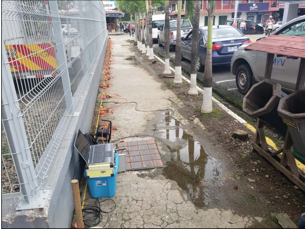
Fotografía 1: Ejecución de ensayo MASW-1
