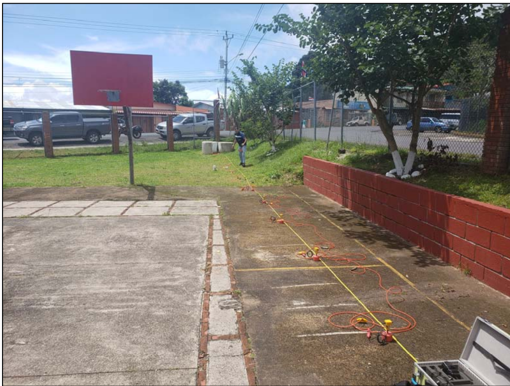
Fotografía 2: Ejecución de ensayo MASW-9
