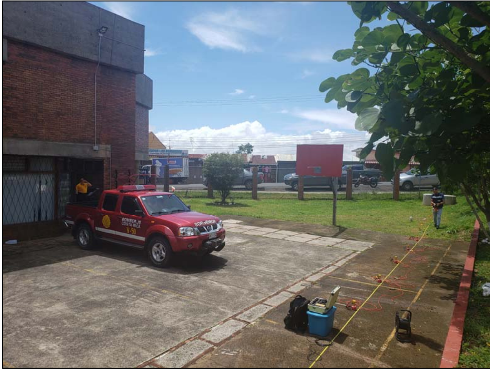
Fotografía 1: Ejecución de ensayo MASW-9
