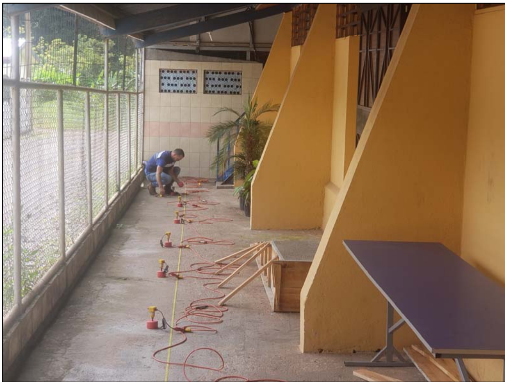
Fotografía 2: Ejecución de ensayo MASW-8
